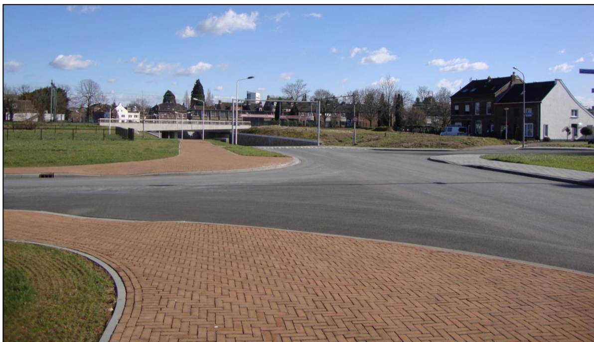
Gedeelte Balijeweg en aan weerszijden gelegen talud en groenstrook, behorende tot het plangebied
